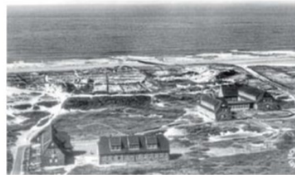
Luftbild der Anlage auf Norderney Mitte der 50er-Jahre.
